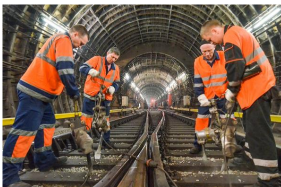
Рис.18. Монтеры железнодорожного пути
