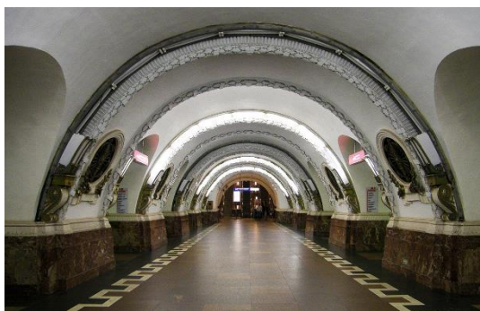
Рис. 12. Станция Площадь Восстания
